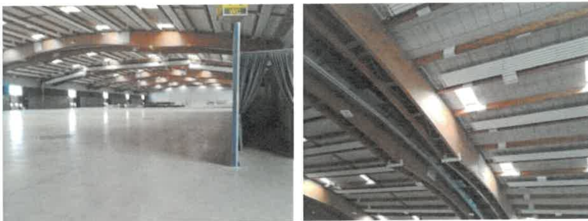
Interno dell'edificio con dettaglio della travatura e delle termostrisce
